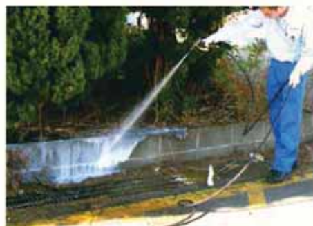
専門業者による液剤の高圧散布
